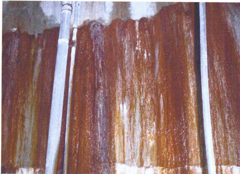
**Fig.3.2 – Particolare infiltrazioni d'acqua**
